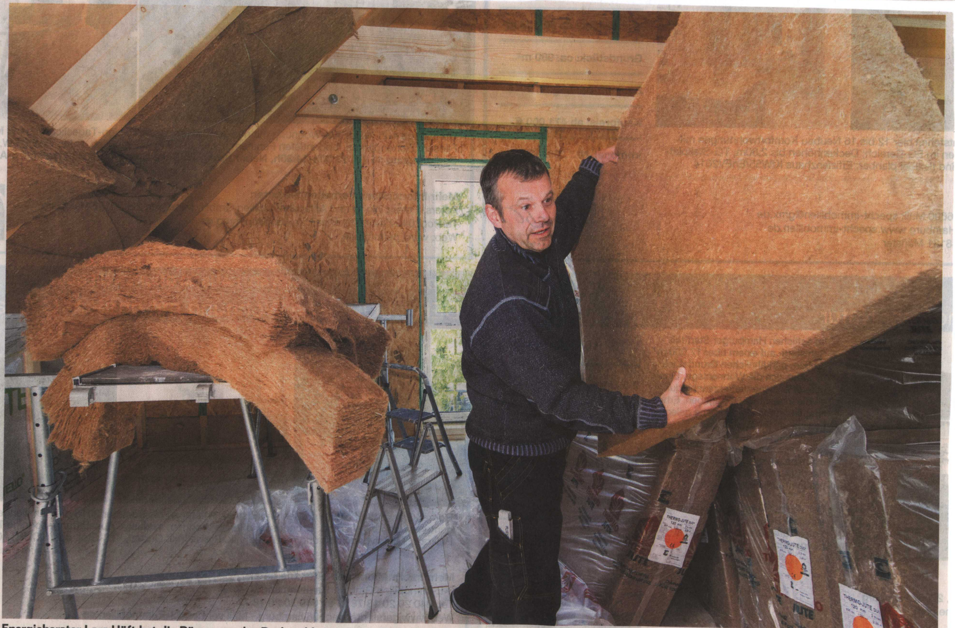
Energieberater Lars Höft hat die Dämmung des Dachstuhls in seinem Haus, Baujahr 1974, selbst in die Hand genommen
