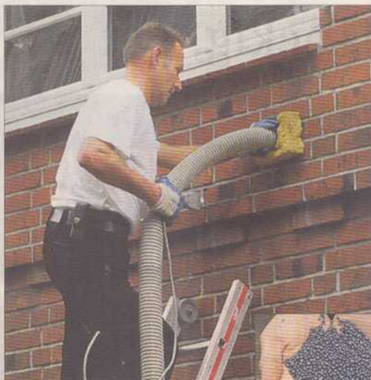
Klinkerfassaden können durch Einblasen eines Dämmstoffes wie Rigipol (Polystyrolgranulat mit Graphit, r.) gedämmt werden. FOTO: P. PIEL
